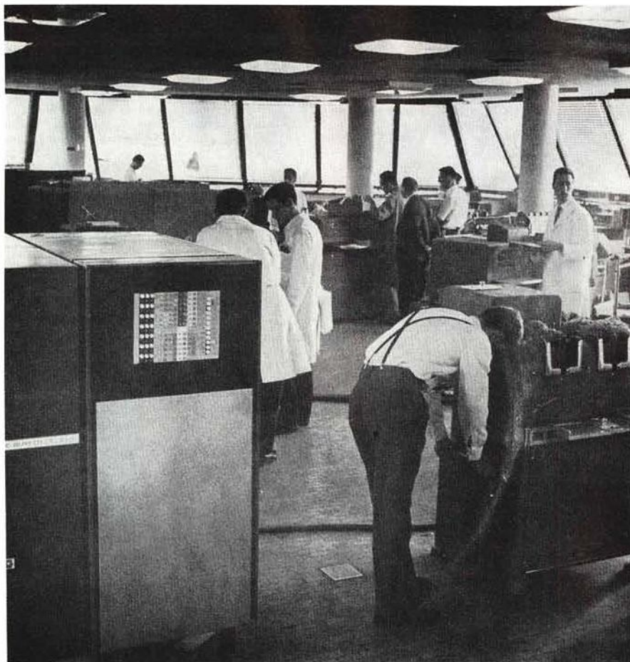
La tabulatrice era capace di compiere le quattro operazioni meccanicamente e di essere programmata per mezzo di appositi pannelli di connessione, la cui predisposizione richiedeva un'elevata specializzazione.
